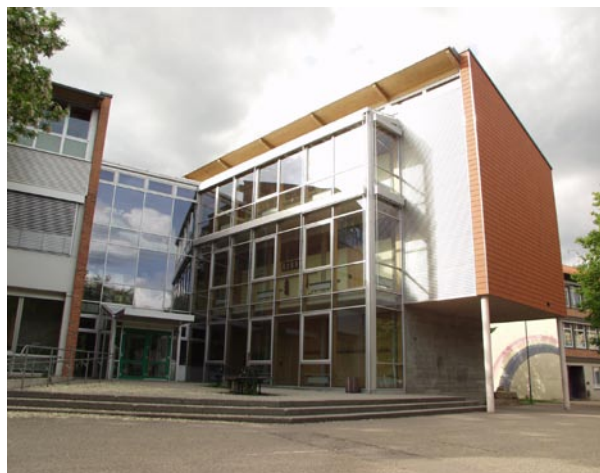
Erweiterungsbau aus dem Jahre 2000
